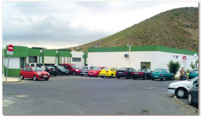
In direkter Nähe zum Gesundheitszentrum und dem neuen Krankenhaus in El Mojón soll eine Feuerwache gebaut werden
