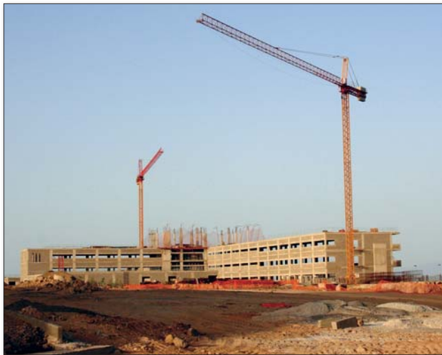
Der Bau des neuen Südkrankenhauses soll 2009 abgeschlossen sein
