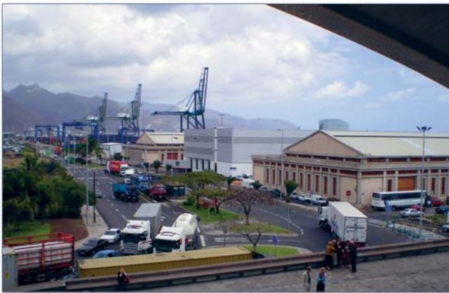
Im Hafen von Santa Cruz sollen künftig 400 Container mehr gelagert werden können
