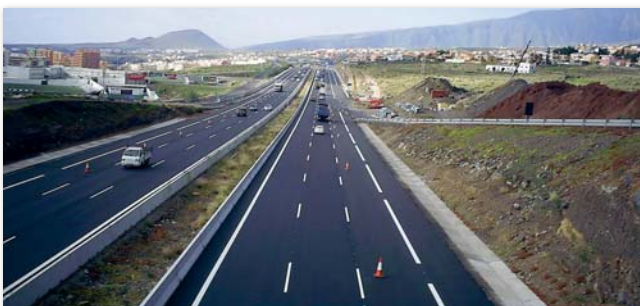
Die Arbeiten zum Ausbau der TF-1 zwischen Santa Cruz und Tabaja schreiten gut voran
